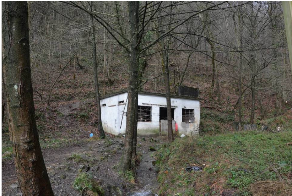
Edificio de compresores
