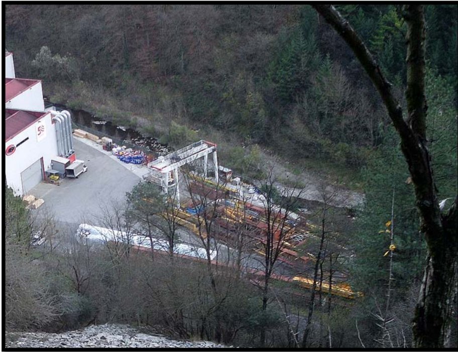
Vista aérea del río Oria en la zona de la empresa JASO Industrial Cranes
