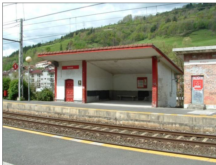
Apeadero de la línea de tren Madrid- Irun.
