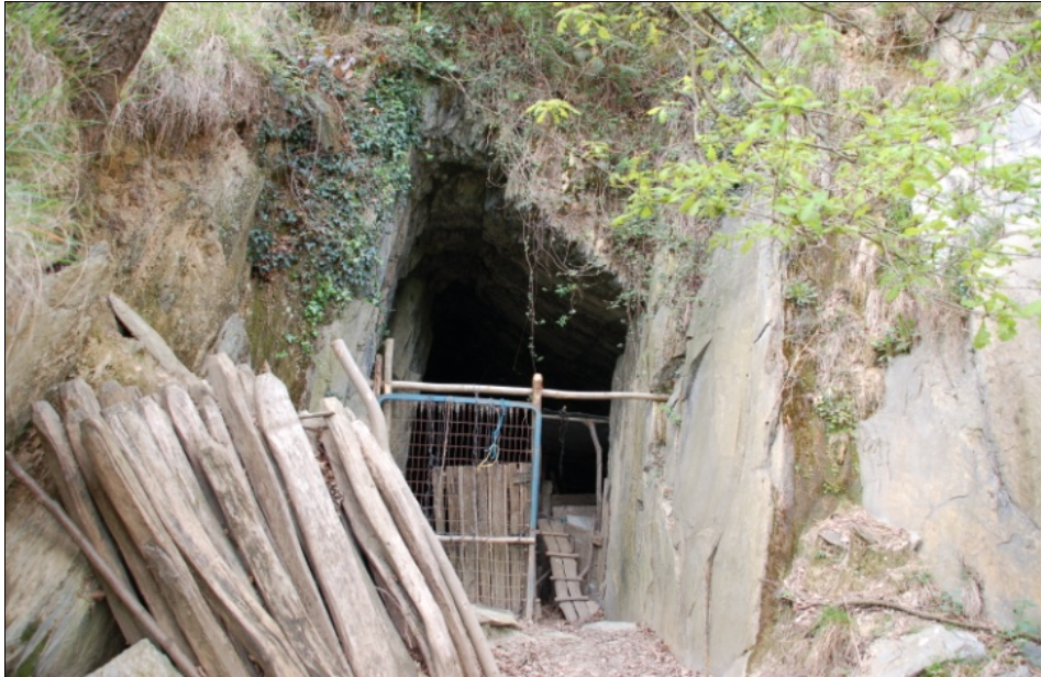
MINA SANTA BARBARA - Cota 285 m
