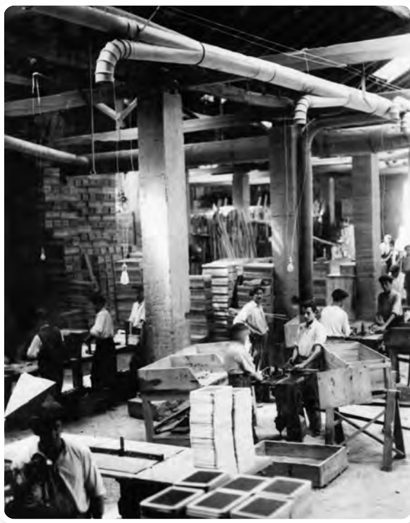
Talleres de Ibarra. Anclado a las cerchas de la cubierta, el sistema de aspiración para el polvo de pizarra.
