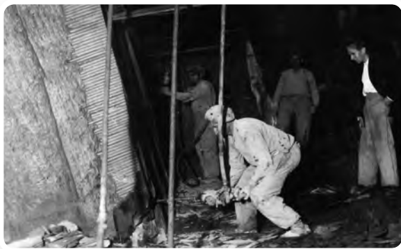
Trabajadores realizando una prueba de taladros con martillos neumáticos. A la derecha, Gurutz Sarasola Martínez.
