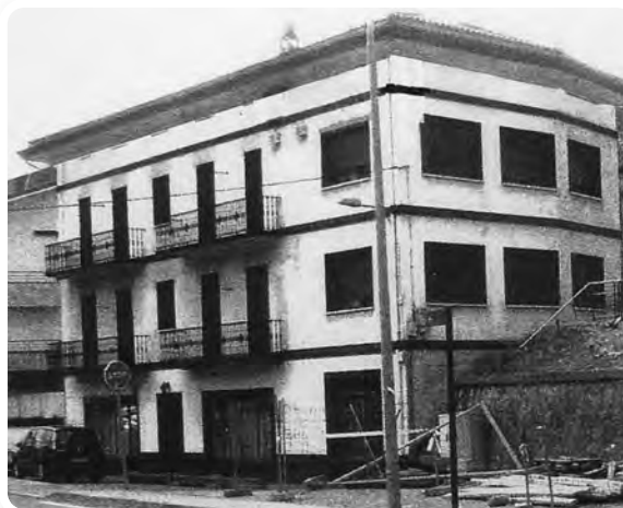
Casa Fernando Enea, reformada como sede de Pizarrerías Sarasola . La planta baja se dedicaba a almacén, el primer piso a oficinas y la segunda planta a vivienda para la dirección de la empresa.
