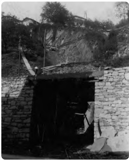
Beheko Zulo y vías de arrastre hasta los talleres.
