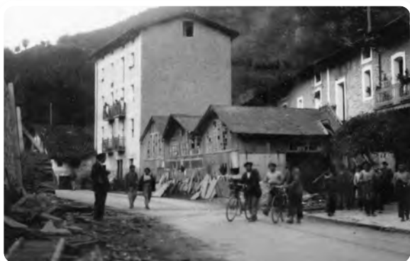
Instantánea de Beheko Kale. A la izquierda, la salida de Beheko Zulo. A la derecha, los primeros talleres de Pizarrerías Sarasola y, en primer término, la casa Sarasola Enea.
