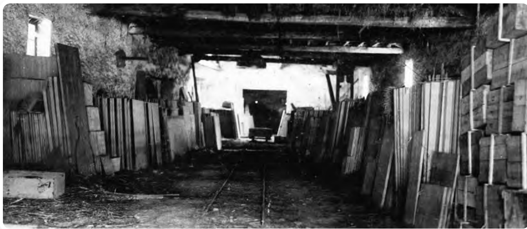
Interior del almacén de expedición de tableros de pizarra. Las piezas debían almacenarse en posición vertical, para impedir que se rompieran. También se disponían tacos de madera entre ellas para separarlas y evitar su ruptura.
