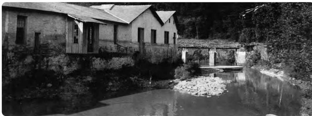
Fachada trasera de la fábrica de Beheko Kale. Al fondo, un puente de madera con soportes de piedra que conectaba los talleres con las escombreras. En el río pueden verse los escombros acumulados durante los primeros años de la explotación.
