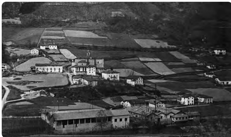
Vista de Itsasondo. En primer término, junto al río Oria, los talleres de Ibarra. Se distingue el secadero (a la izquierda), abierto en su fachada al río y adosado al taller mecánico, con tres ventanas. A la derecha, las naves de producción, con sus tejados seriados a dos aguas.
