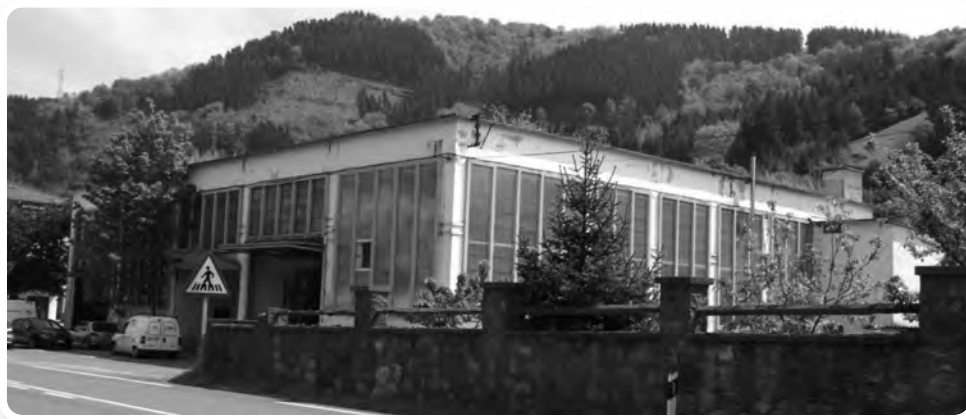
Nuevos talleres de Pizarrerías Sarasola. En este moderno edificio, construido en el lugar que ocupaban los talleres de Ibarra, se unificó todo el proceso productivo que, hasta entonces, se realizaba disperso en Beheko Kale, Izarre (Fabrika Zaharra) e Ibarra.
