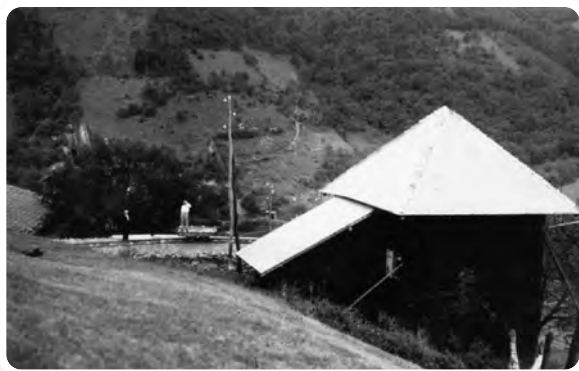
Castillete de Mendibil y vía de arrastre que lo comunicaba con las galerías de Malkorra.
