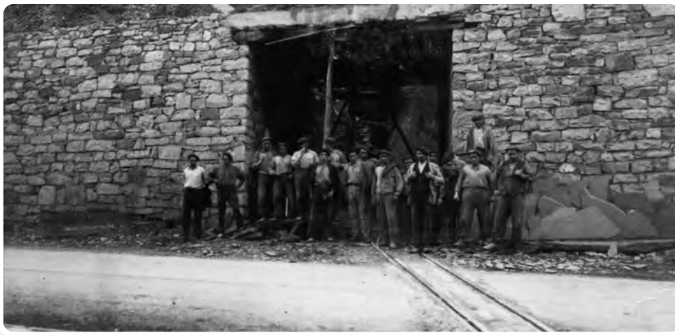
Trabajadores de Pizarrerías Sarasola en Beheko Zulo, por donde se daba salida la pizarra extraída en las galerías de Malkorra. Se aprecian los raíles por los que se desplazaban las vagonetas, tiradas por mulos, hasta los talleres de Beheko Kale.
