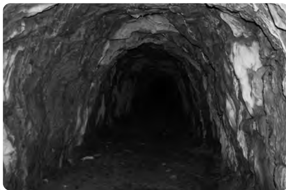
Galería transversal a Izarre. Esta galería se excavó en la concesión. El Ángel de la Guarda para intentar alcanzar los filones de pizarra desde la ladera S del Murumendi.
