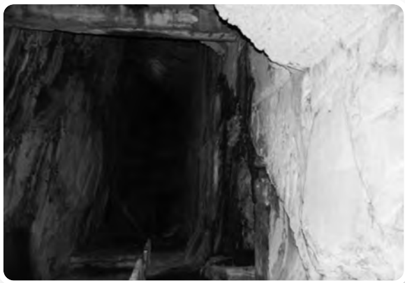
Galería para la extracción de la pizarra en la zona de Malkorra.
